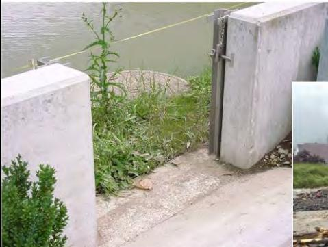
Die Hochwasserschutzmauer mit Durchlass dient dazu, dass bei tieferen Wasserständen das Bachbett der Engleberger Aa zugänglich bleibt. Dies erlaubt die Ausführung von Unterhaltsarbeiten oder einen vereinfachten Zutritt für Badegäste. Bei Hochwassergefahr wird die Öffnung mit Dammballen verschlossen, damit das Wasser nicht aus dem Bachbett treten kann. B&B Hochwasserschutzmauer an der Engleberger Aa in Oberdorf, Kanton NW 26.08.2005
