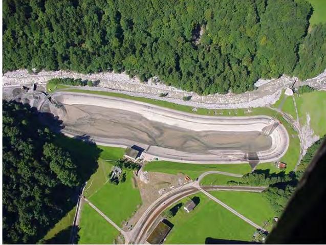
Das Ausgleichsbecken Obermatt der Kraftwerke Engelbergeraa AG befindet sich an der Engelberger Aa zwischen Engelberg und Grafenort. Ein Teil des Abflusses der Engelberger Aa wird mit dem Tirolerwehr gefasst und über eine Entsanderanlage in das Ausgleichsbecken geleitet. Bild: Ausgleichsbecken Obermatt der Kraftwerke Engelbergeraa AG, Kanton NW 2005
